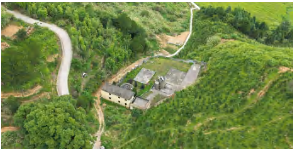
图5.1-2 天湖水厂现状照片
