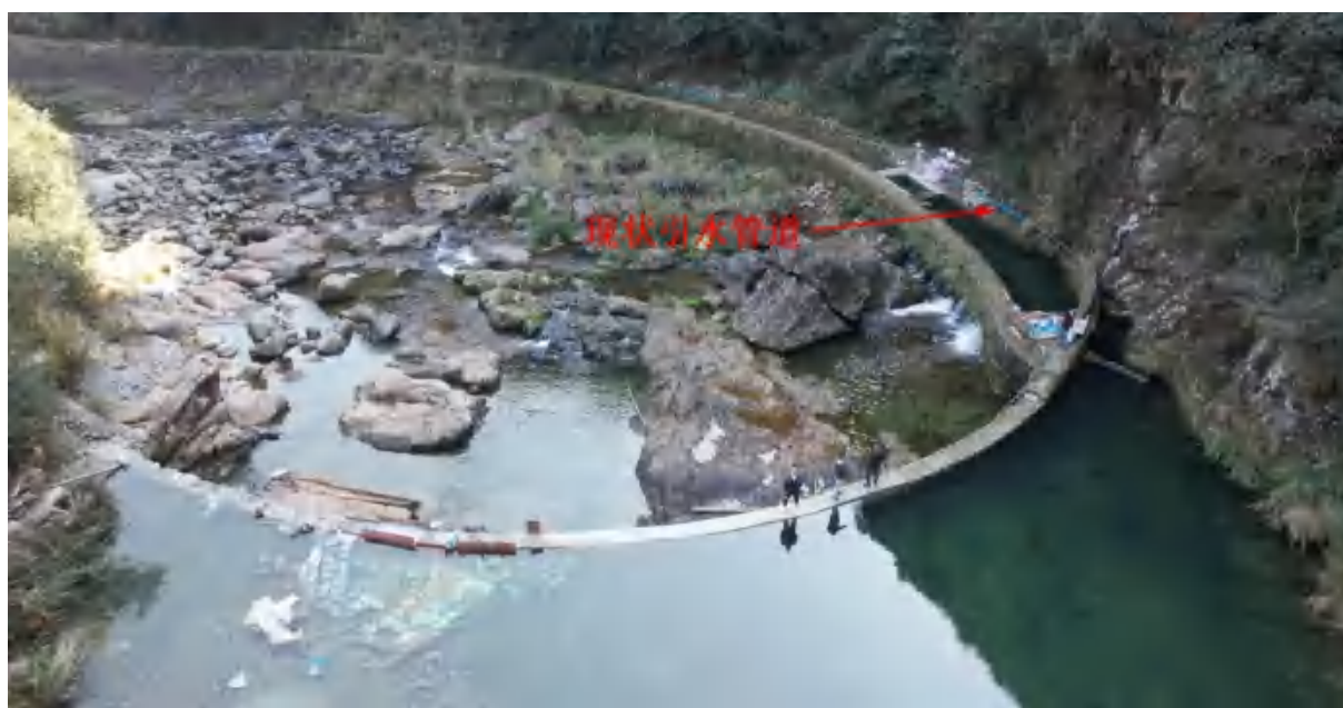
现状取水口、引水管道
