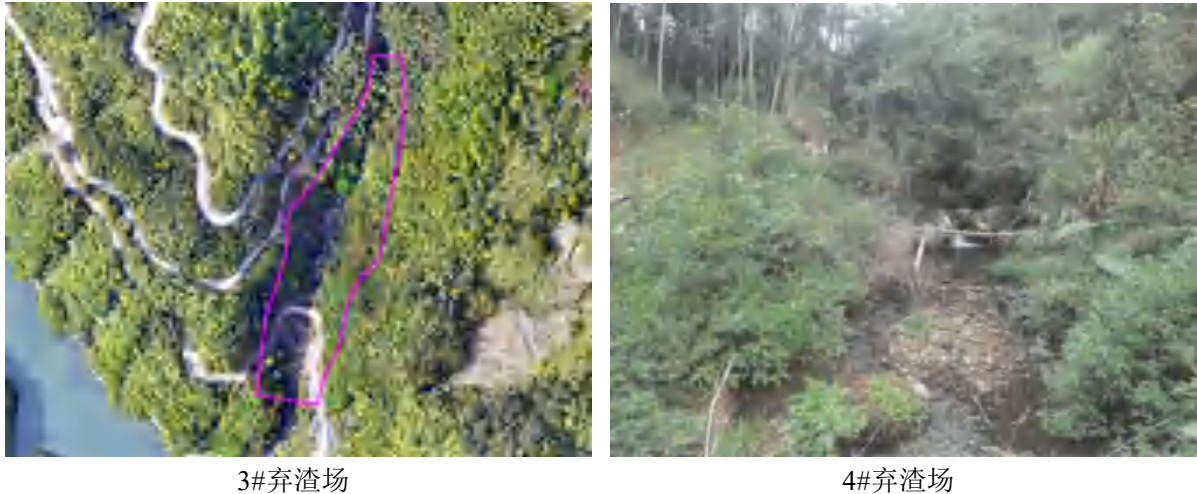
图4.2-11 施工临时设施现状照片
