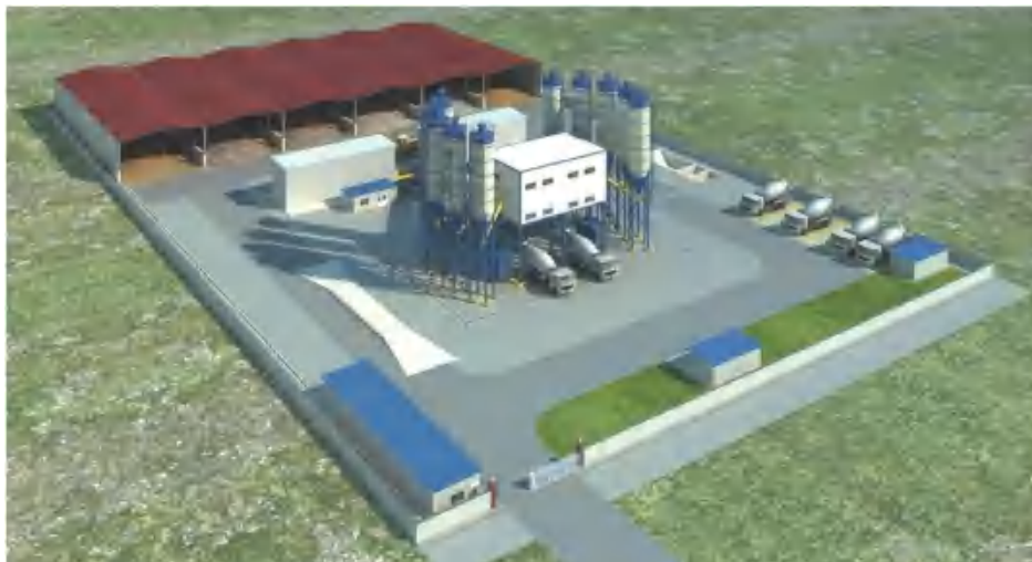
图3.2-19 标准拌合站布置示意图
